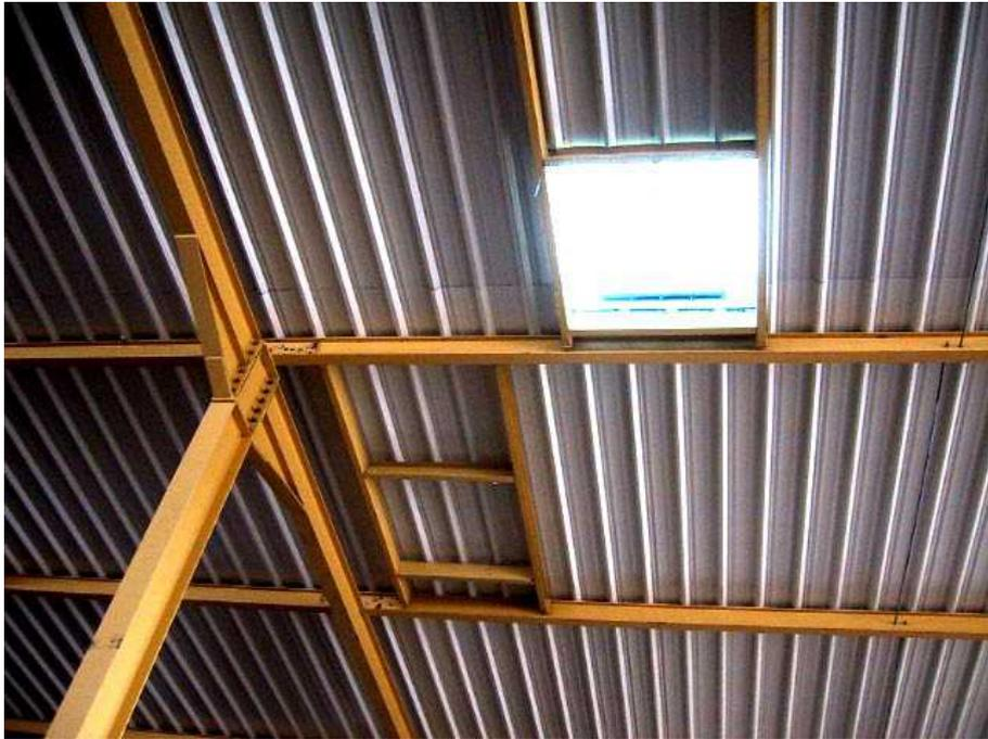
*Exemple de Bac acier support d'étanchéité - Centre commercial à Mulhouse*
