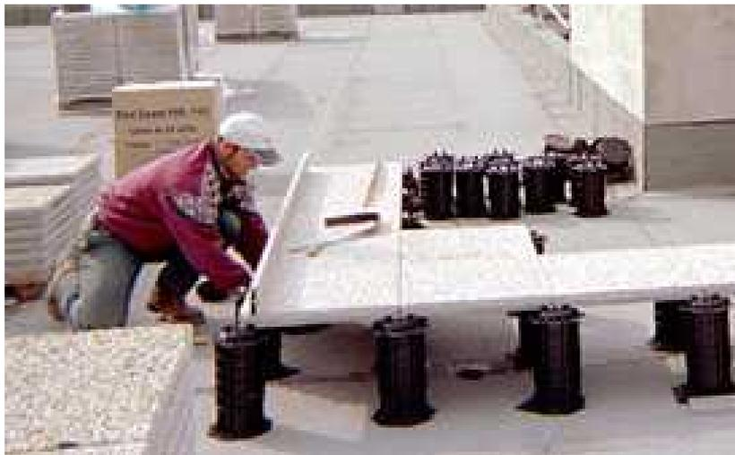
*Pose de dalles sur plots en béton désactivé*
