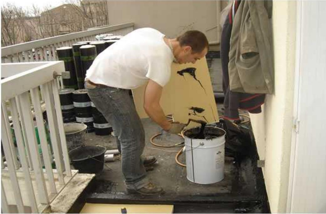
*3 - Pose de l'isolant (application d'une colle bitumineuse)*
