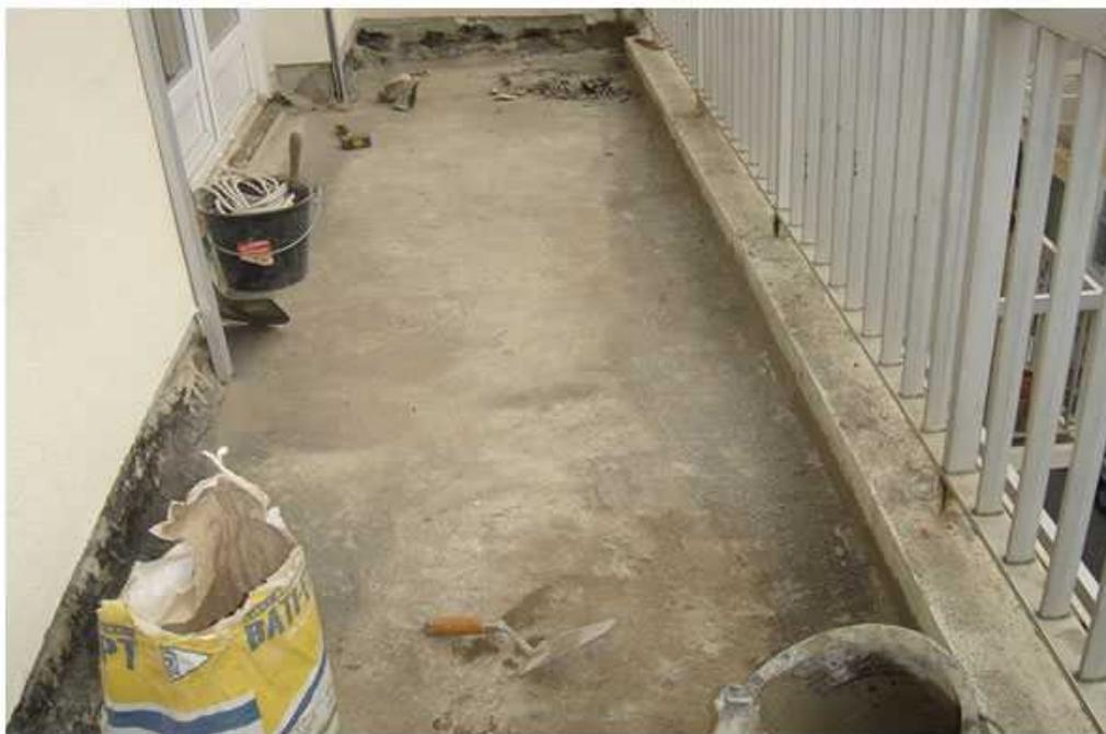
1 - Préparation du support (porteur : dalle en béton armé)
