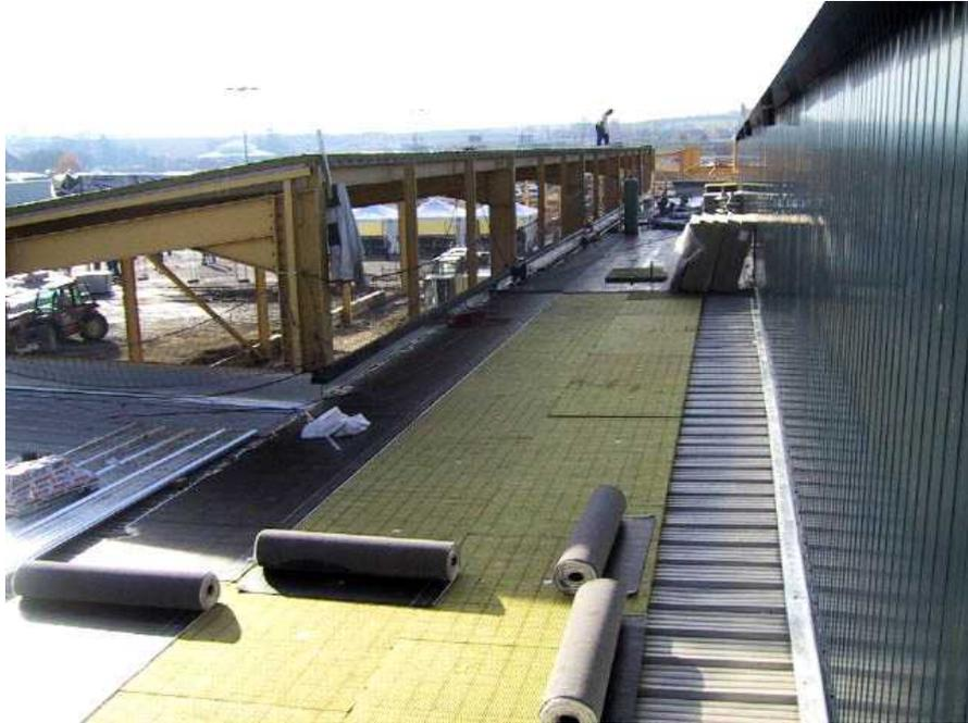
*De droite à gauche : Tôle d'Acier Nervurée (TAN), Isolant (laine de roche avec pare-vapeur intégré en sous-face), 1ère couche d'étanchéité avec écran d'indépendance intégré (bicouche)*
